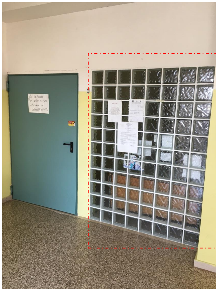
Intervento sulla compartimentazione della scala
